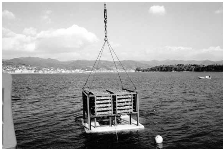
(図表11) JFシェルナースの沈設状況
