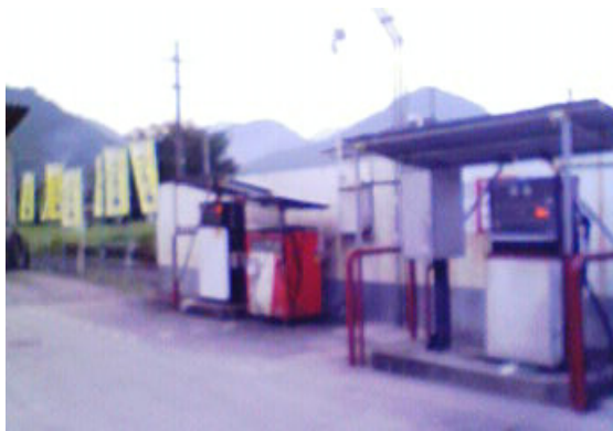
(老朽化した洗車機及び給油機たち)
