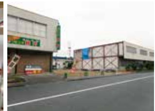
連棟建物の中間施設撤去工事完了
