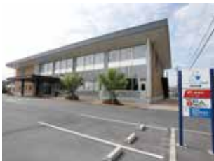
新組合会館(隣接の駐車場へ 組合会館を移転新築)
