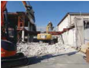
連棟建物一部解体撤去工事
