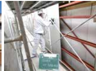
一部撤去後の隣接建物の壁面補修工事
