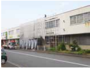
解体工事前の連棟建物
