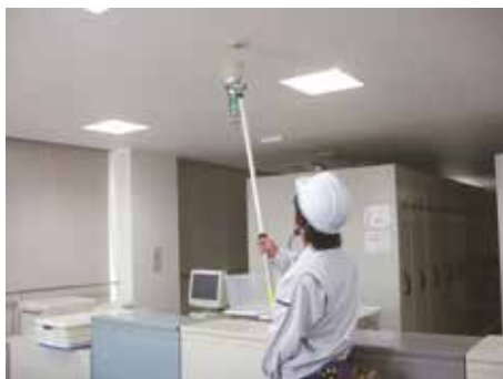
法令遵守による保守点検
